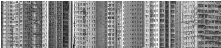
5 - Tipici edifici residenziali a torre di Hong Kong ad alta densità abitativa, dovuta all'esiguità di spazio disponibile in questa città, ma comunque rappresentativi della normale prassi edificatoria in tutto il mondo.
